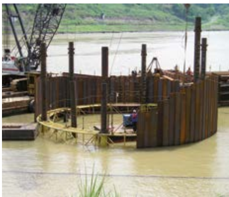
2. Установка свай до замыкания ячейки
