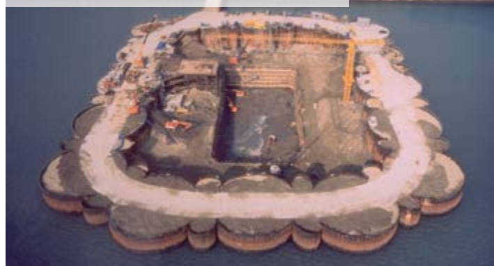
Строительство моста, Южная Корея
